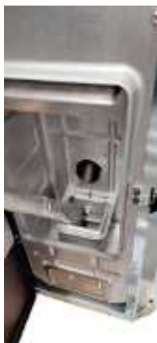
Fig. 35 - Rengøring af fyrfadsrum
