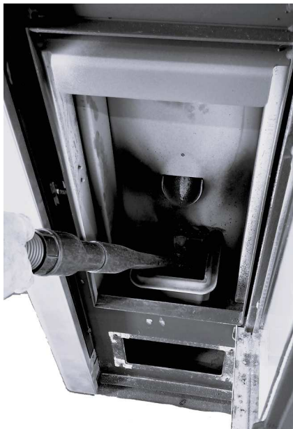
Fig. 32 - Rengøring af fyrfadsrum
