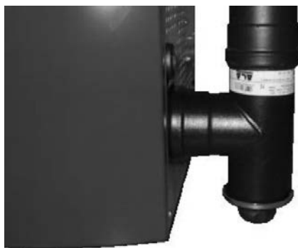
Fig. 73 - Rengøring af røgkanal
