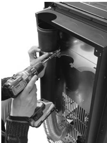
Fig. 63 - Blokér slangen - diameter 80 mm
