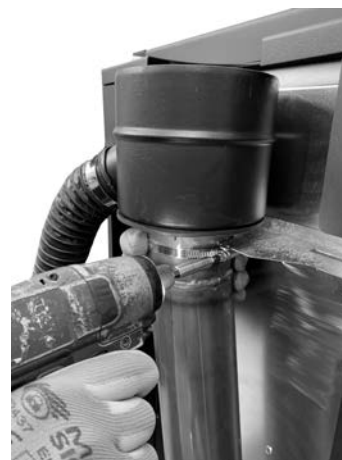
Fig. 48 - Blokér med klemmebøjlen
