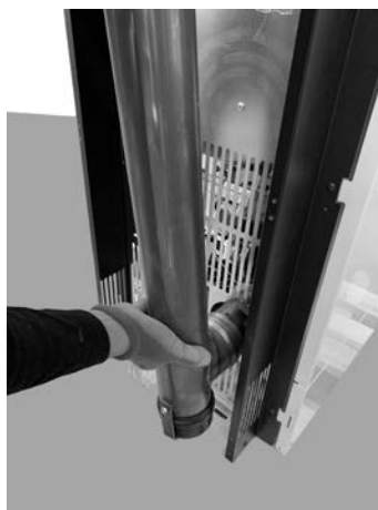
Fig. 47 - Indsæt slangen - diameter 80 mm
