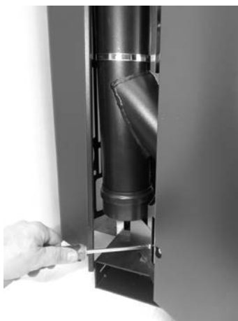
Fig. 65 - Løsn lukkeren
