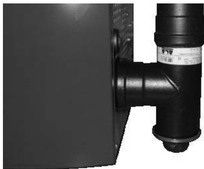
Fig. 63 - Rengøring af røgkanal
