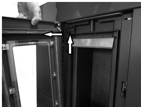
Fig. 53 - Afmontering af låge
