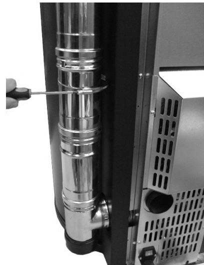
Fig. 103 - Trækkkanalerne (Sfera³ Plus, Sfera³, Globe).
