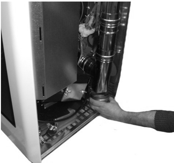
Fig. 102 - Rengøring af røgkanal
