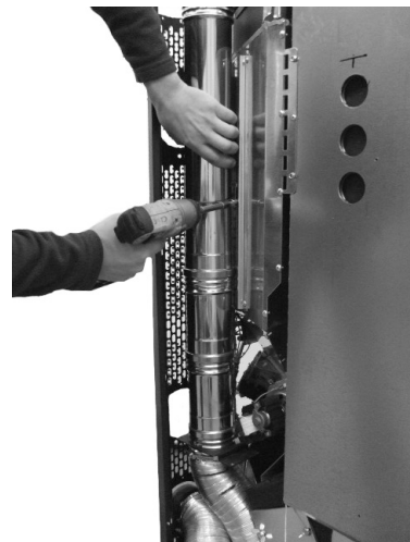
Fig. 64 - Fastgørelse af rør
